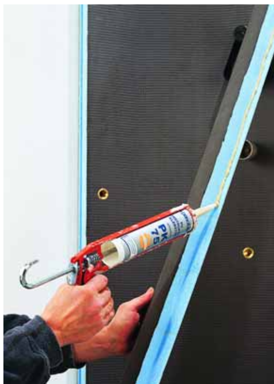
4. Соединительные элементы склеиваются с помощью PU клея.
