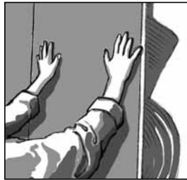
С Прижмите плиту к стене и выровняйте ее.
