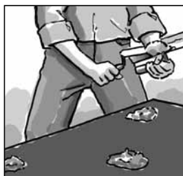
Нанесите цемент на метки, проделанные на плитах.
