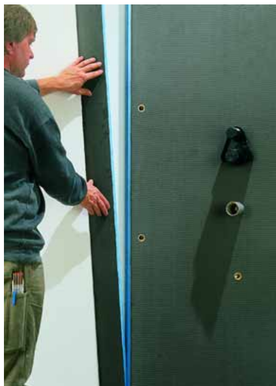
4. Соединительные элементы склеиваются с помощью PU клея.
