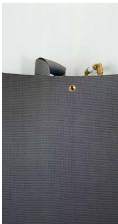
6. Проверьте трубы и соединения на баропрочность.
