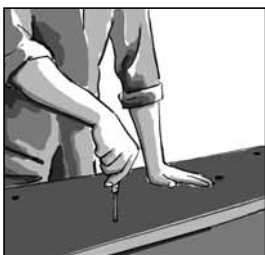
С помощью отвертки проделайте отверстия – метки для нанесения мазков раствора.
