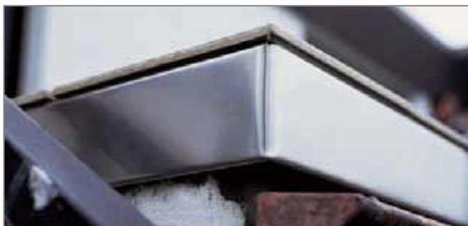
Процесс тонкослойной укладки профиля wedi Balco
